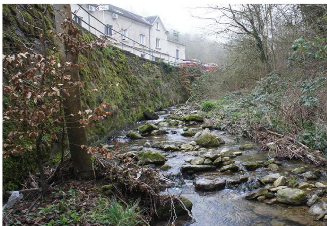
Foto gegen Fließrichtung
