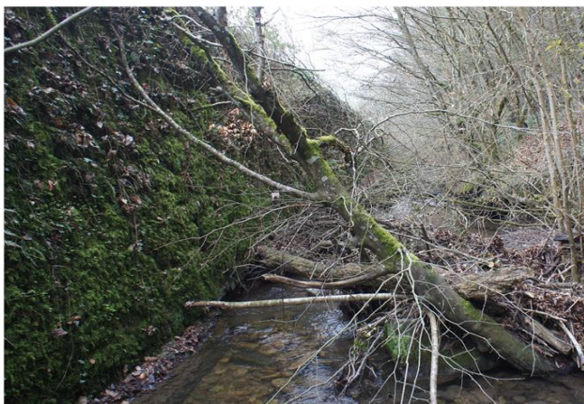
Foto gegen Fließrichtung
