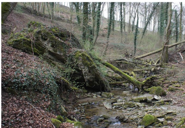
Foto gegen Fließrichtung
