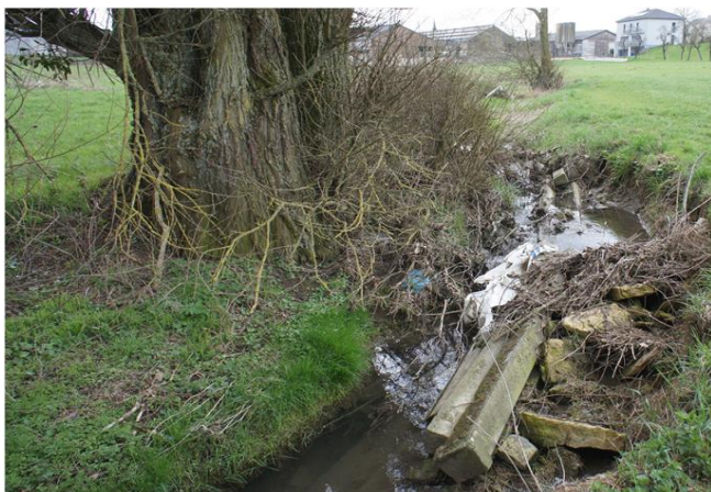
Foto gegen Fließrichtung
