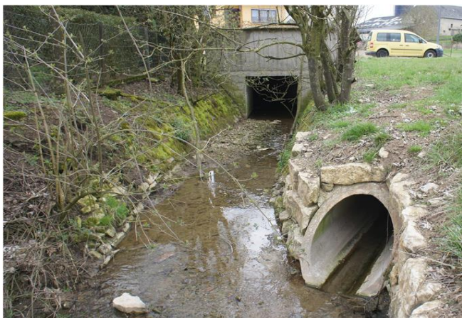
Foto gegen Fließrichtung
