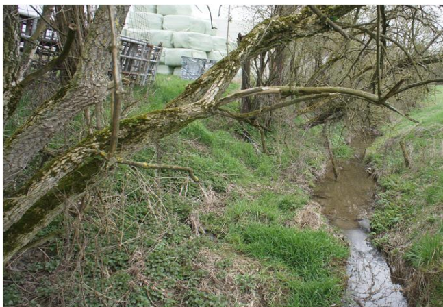
Foto gegen Fließrichtung
