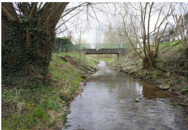
Foto gegen Fließrichtung
