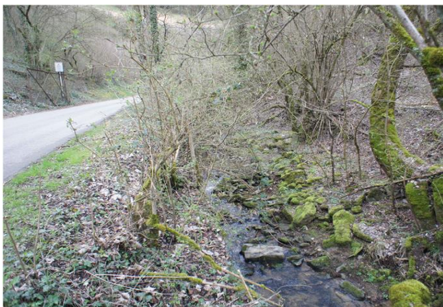
Foto gegen Fließrichtung
