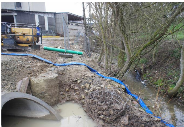
Foto gegen Fließrichtung
