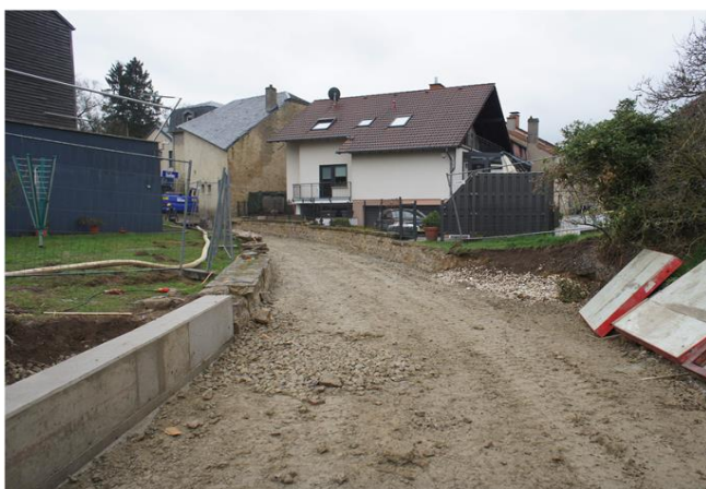
Foto gegen Fließrichtung
