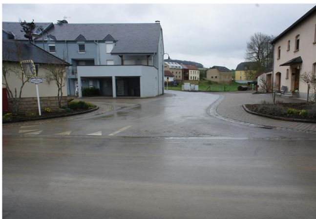
Foto gegen Fließrichtung
