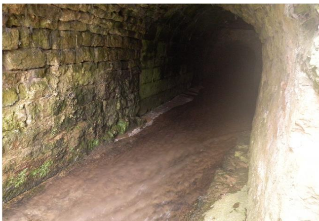
Foto gegen Fließrichtung
