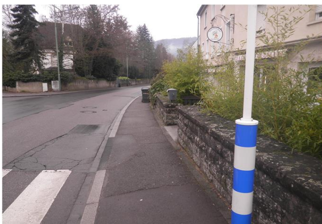
Foto gegen Fließrichtung
