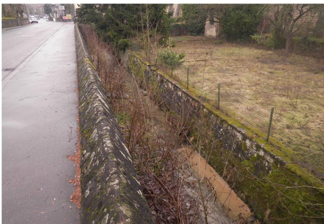
Foto gegen Fließrichtung
