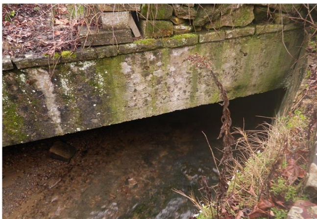
Foto gegen Fließrichtung
