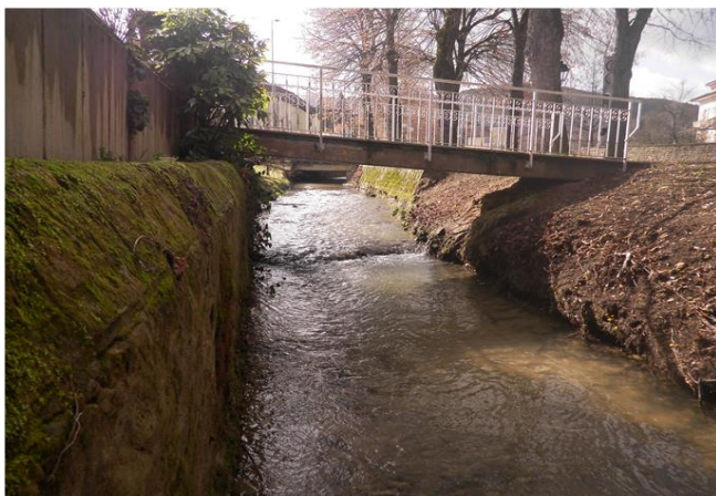
Foto gegen Fließrichtung
