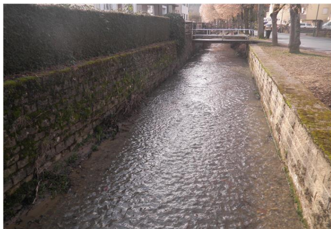
Foto gegen Fließrichtung
