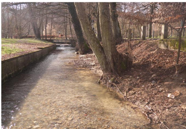
Foto gegen Fließrichtung
