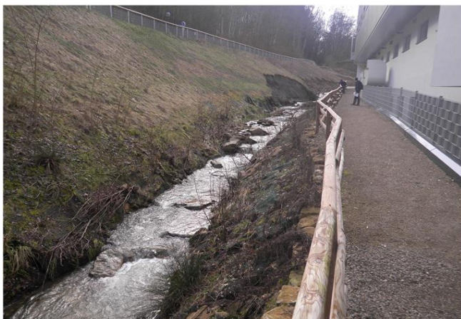
Foto gegen Fließrichtung
