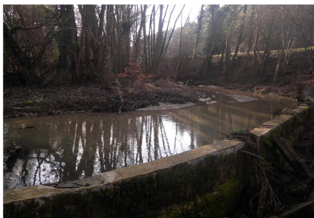
Foto gegen Fließrichtung
