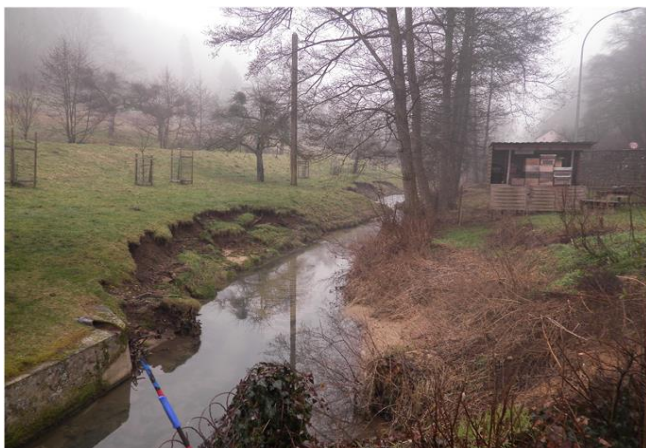
Foto gegen Fließrichtung
