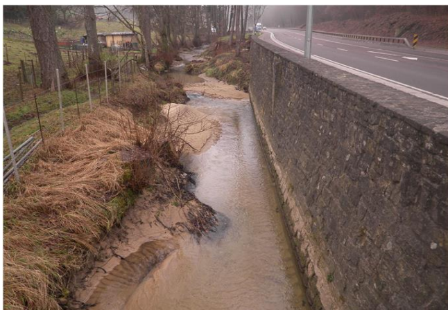
Foto gegen Fließrichtung
