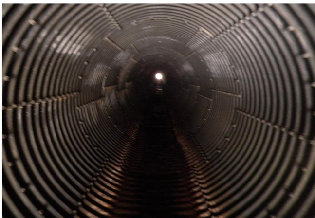
Foto gegen Fließrichtung
