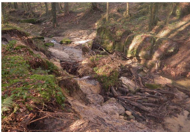
Foto gegen Fließrichtung
