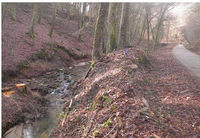
Foto gegen Fließrichtung
