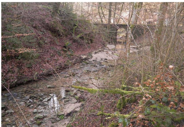
Foto gegen Fließrichtung
