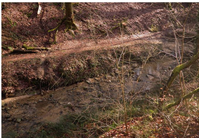
Foto gegen Fließrichtung
