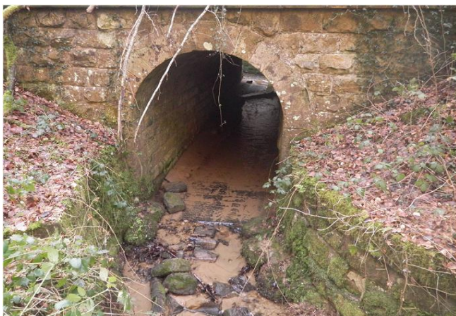
Foto gegen Fließrichtung
