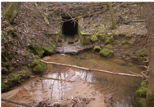
Foto gegen Fließrichtung
