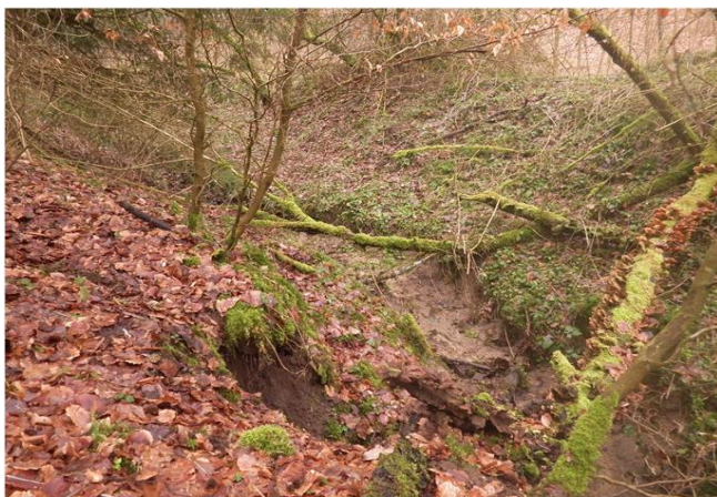
Foto gegen Fließrichtung
