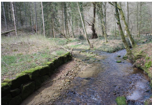
Foto gegen Fließrichtung
