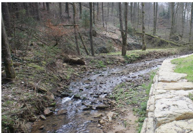
Foto gegen Fließrichtung
