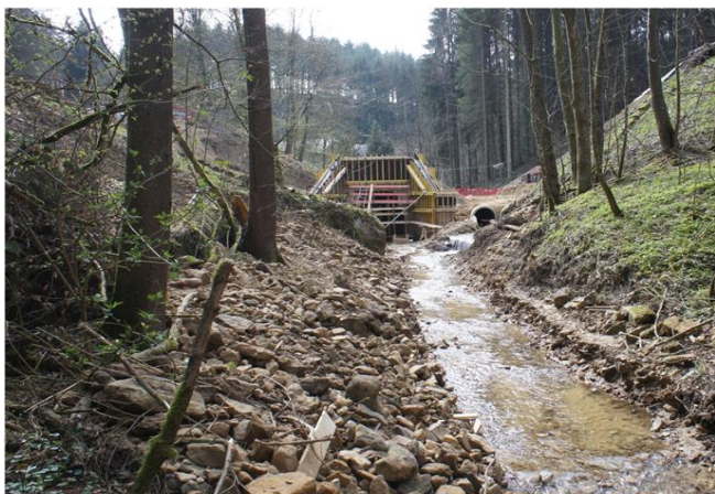
Foto gegen Fließrichtung
