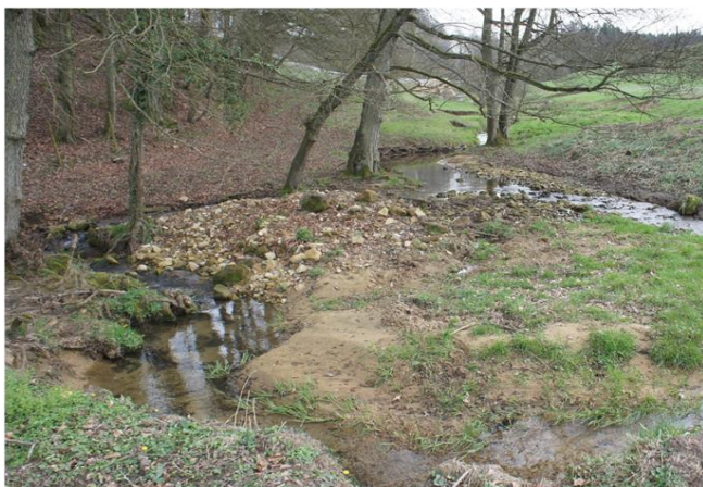
Foto gegen Fließrichtung
