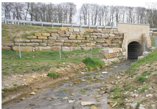
Foto gegen Fließrichtung
