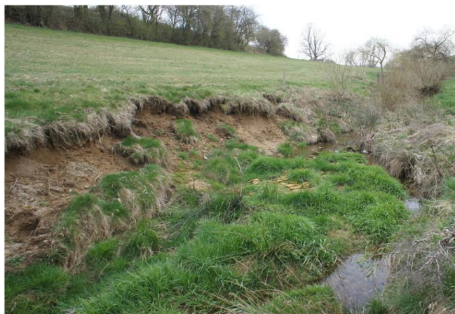
Foto gegen Fließrichtung
