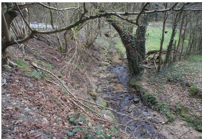
Foto gegen Fließrichtung
