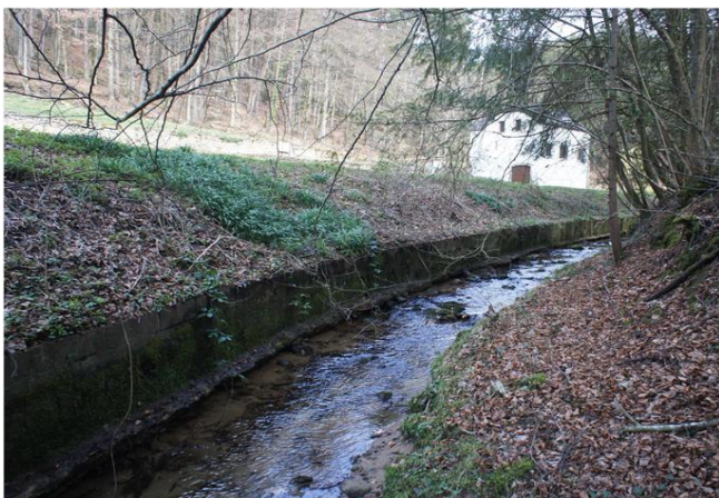
Foto gegen Fließrichtung
