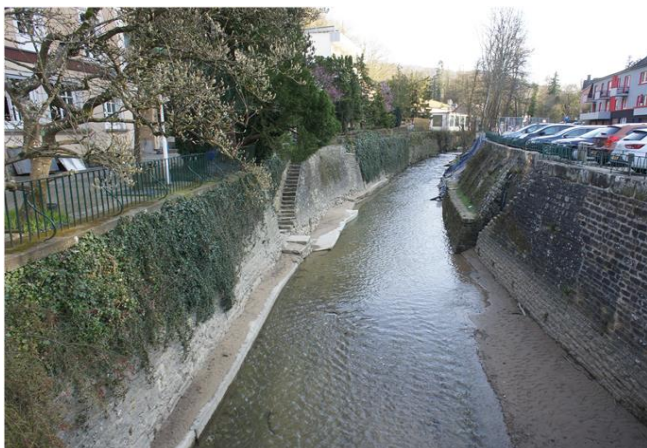
Foto gegen Fließrichtung
