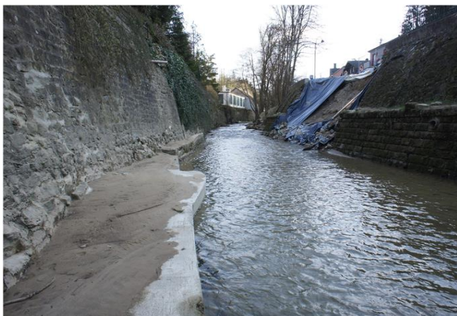
Foto gegen Fließrichtung
