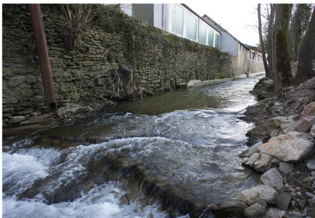
Foto gegen Fließrichtung
