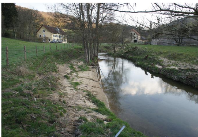
Foto gegen Fließrichtung
