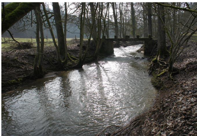
Foto gegen Fließrichtung
