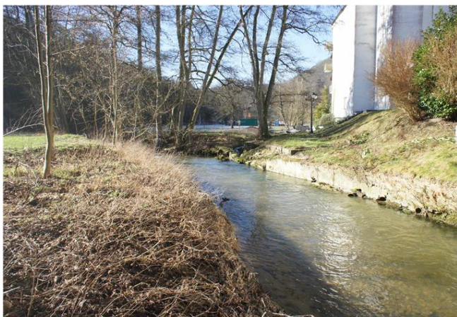
Foto gegen Fließrichtung
