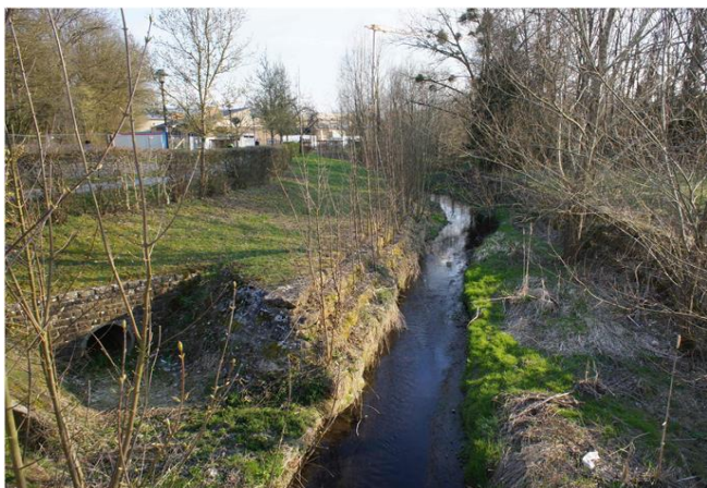
Foto gegen Fließrichtung
