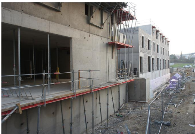
Foto gegen Fließrichtung
