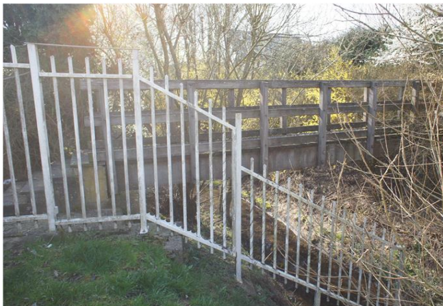
Foto gegen Fließrichtung
