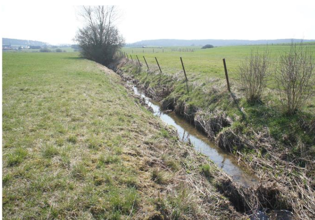
Foto gegen Fließrichtung
