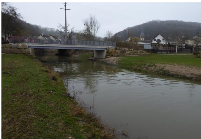
Foto gegen Fließrichtung
