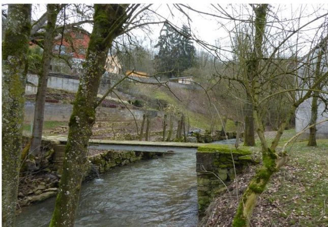
Foto gegen Fließrichtung
